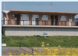
トイレ・シャワー棟
